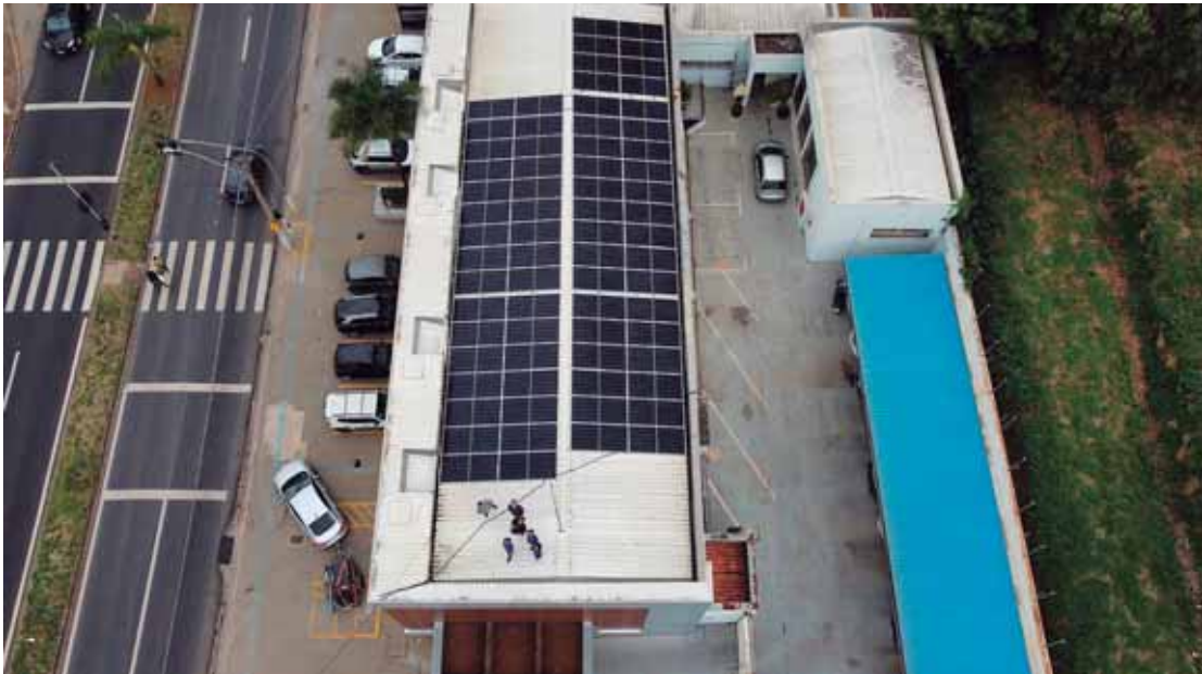
A instalação das placas solares ocorreu em outubro e a ativação do sistema, em novembro
