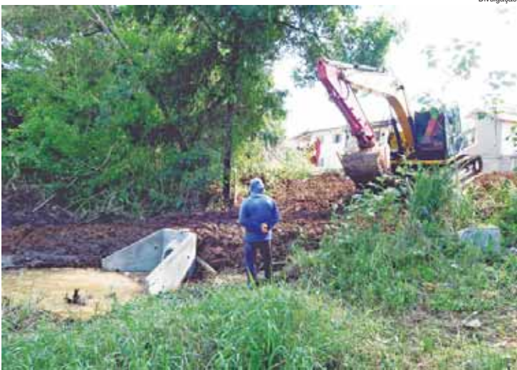
Obras iniciaram com a execução do sistema de drenagem, com instalação de tubulação e muro de ala
